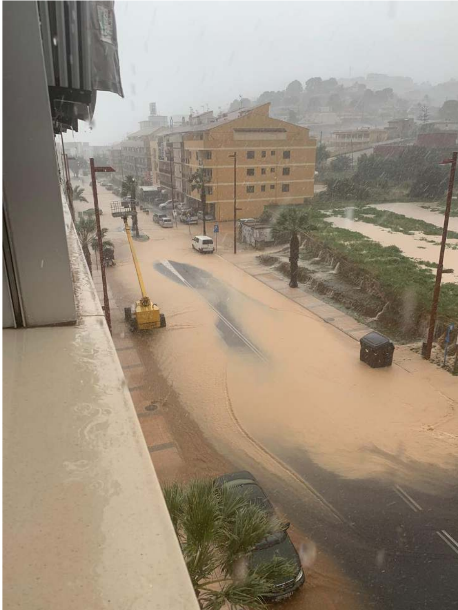
Problemas ocasionados en Peñíscola por las fuertes lluvias (01 de abril del 2020)
